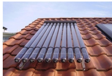
Capteurs solaires thermiques
