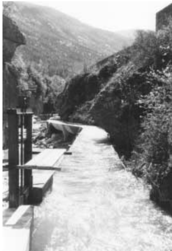
Canal d'aménée en éléments préfabriqués.
