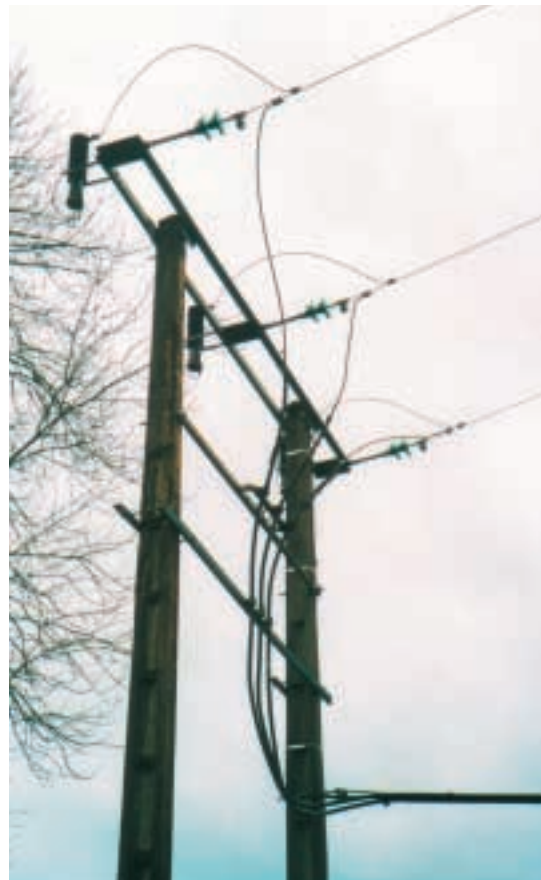
Départ en 20 000 volts avec parafoudres
