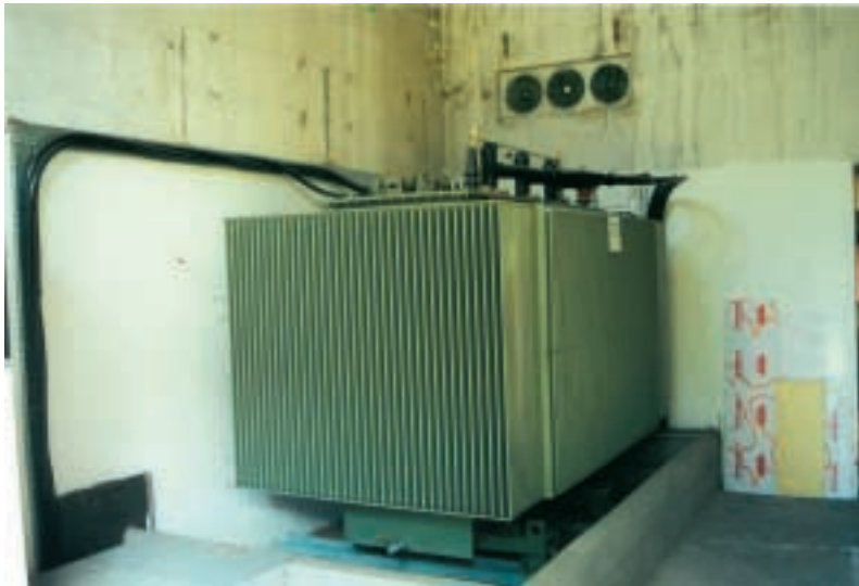
Transformateur intérieur
